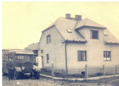
Nový dům čp. 295 v Novém Hrádku s garážemi a autobusem Walter FNA (1934). Foto : archiv Ivy Maršíkové, Náchod.
