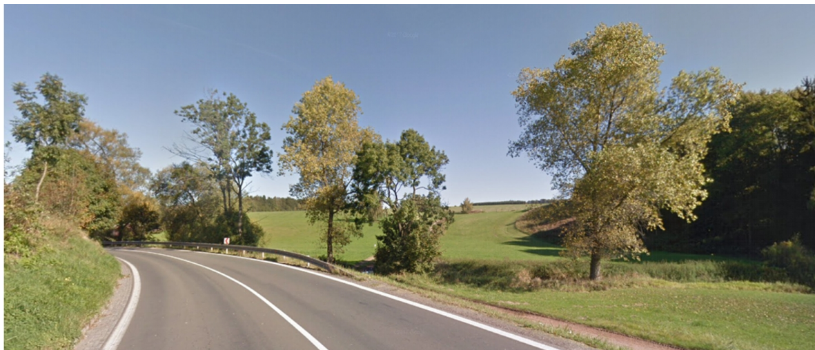
Obr: Místo zaústění přeložky komunikace II/303 na stávající komunikaci v Bukovici
